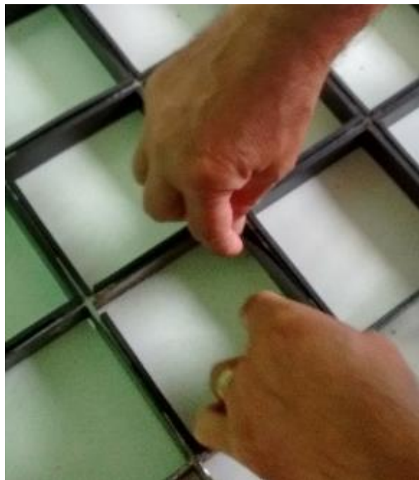
Figura 3.17 – Revestimento do molde para concretagem
