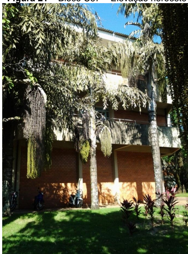
Figura 21 – Bloco C67 – Elevação noroeste
