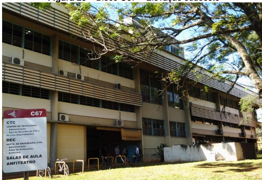
Figura 23 – Bloco C67 – Elevação sudoeste
